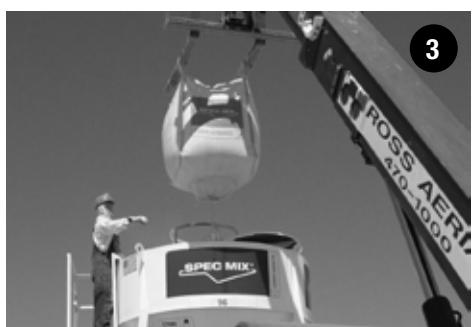
**Paso 3:** Las bolsas a granel se cargan fácilmente en el silo insertando las horquillas a través de los lazos reforzados de la bolsa. Una vez que la bolsa está ubicada sobre el silo y en posición sobre la cubierta de polvo superior, el trabajador que está en la plataforma de seguridad puede liberar los canales de descarga doble de la bolsa.
