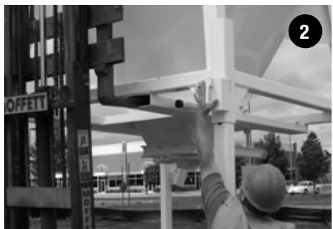
**Paso 2:** Usando los pasadoresdobles de las patas que están acoplados al chasis, asegurar el conjunto superior del silo deslizando los pasadores de las patas a su posición. Después, asegure los pasadores con los pasadores de enganche de seguridad. A continuación, coloque la manilla de la compuerta deslizante en su lugar y prepárese para cargar el producto SPEC MIX en el silo.
